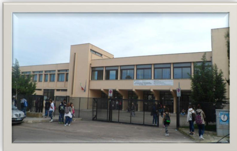
Istituto "N. Moccia" – Sede Centrale di via Bonfante
